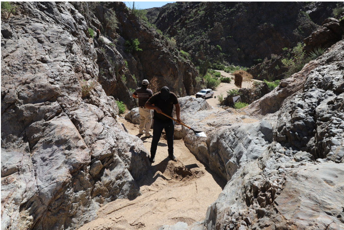
Figura 11. Desazolve de la Tinaja de la Rinconada.
